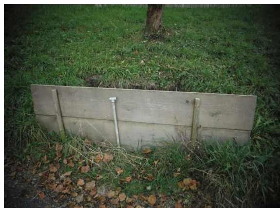
Abbildung 21: Zustand Bacheindolung im Gefällsknick der Leitung, bei Gebäude Nr. 91
