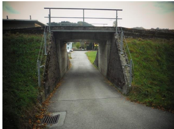
Abbildung 19: Bahnunterführung, Blick gegen Kantonsstrasse
