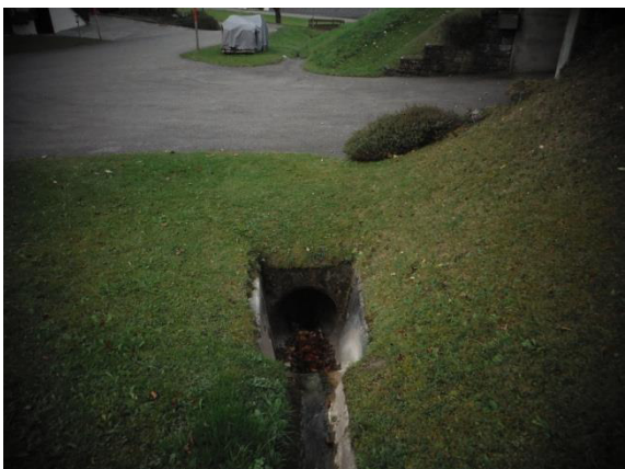
Abbildung 34: Haseleegräbli km 0.500, Blick in Fliessrichtung, bei Gebäude Nr. 94a
