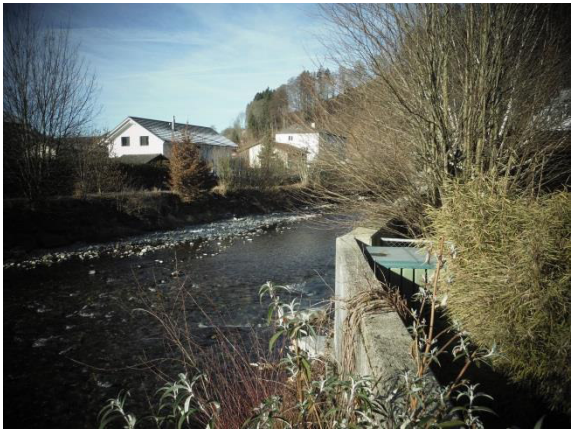
Abbildung 1: Iffis km 8.180, Ansicht ab rechtem Ufer, Blick in Fließrichtung
