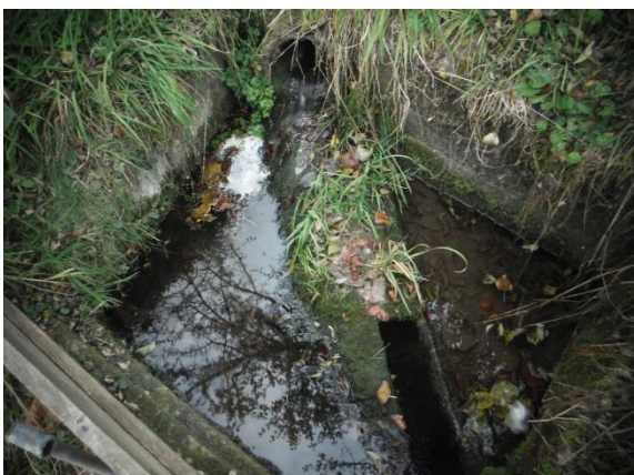
Abbildung 20: Zustand Bacheindolung im Gefällsknick der Leitung, bei Gebäude Nr. 91
