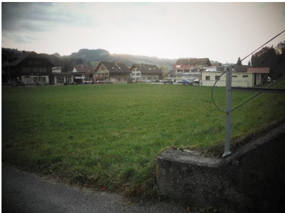
Abbildung 18: Ansicht Götschimatte, Blick gegen Gebäude Nr. 58, bei Bahnunterführung
