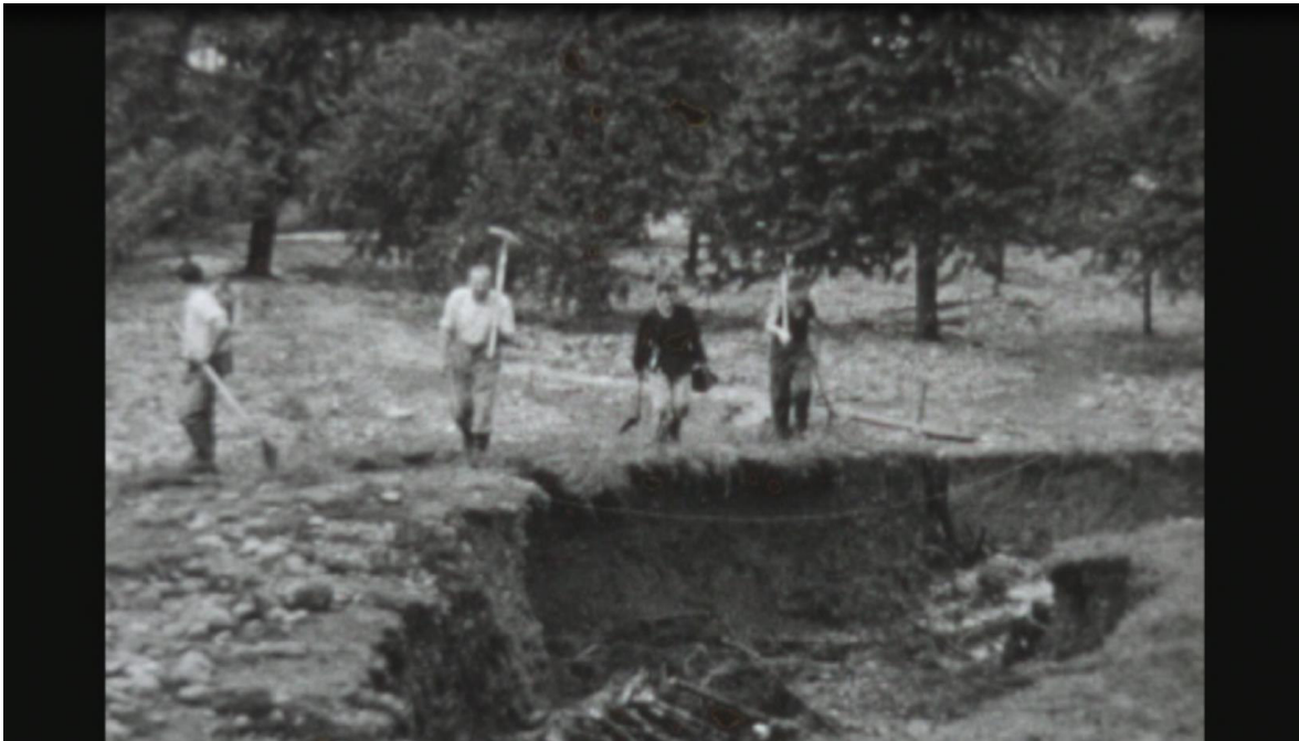
Abbildung 41: Ausschnitt aus dem Film "Wassernot 1953 - Trubschachen", sichtbar sind deutliche Sohlen- und Ufererosionen sowie Spuren der Überflutung und Übersarung
