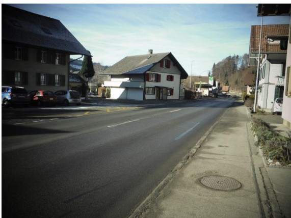
Abbildung 5: Kantonsstrasse bzw. Helvetiaplatz, Blickrichtung Richtung Bern, bei Gebäude Nr. 58
