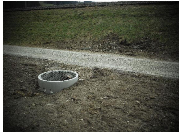
Abbildung 12: Einlauf in Bahndurchlass auf nördlicher Dammseite (ES)
