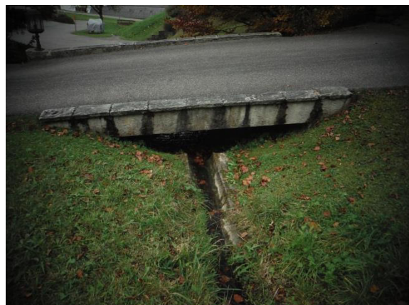
Abbildung 35: Haseleegräbli km 0.520, Blick in Fliessrichtung
