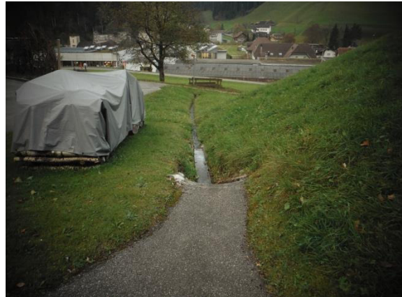
Abbildung 33: Haseleegräbli km 0.495, Blick in Fliessrichtung, bei Gebäude Nr. 94a
