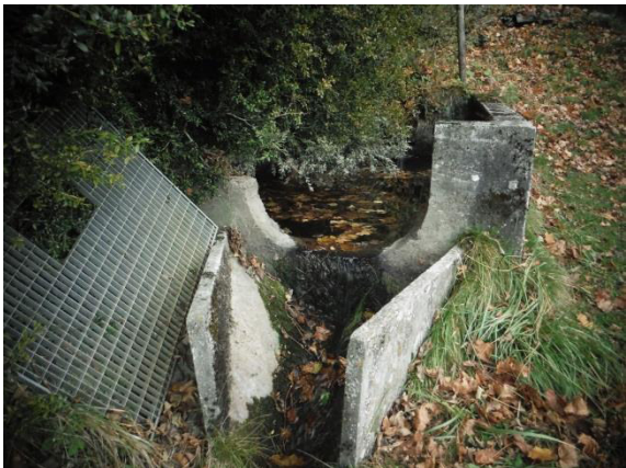
Abbildung 38: Sandfang / Schlammesammler Haseleegräbli (Waldrand), Blick gegen Fließrichtung
