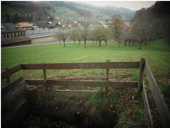
Abbildung 30: Einlauf in Eindolung beim Weiher bei Gebäude Nr. 95, Blick gegen Hasenlehn
