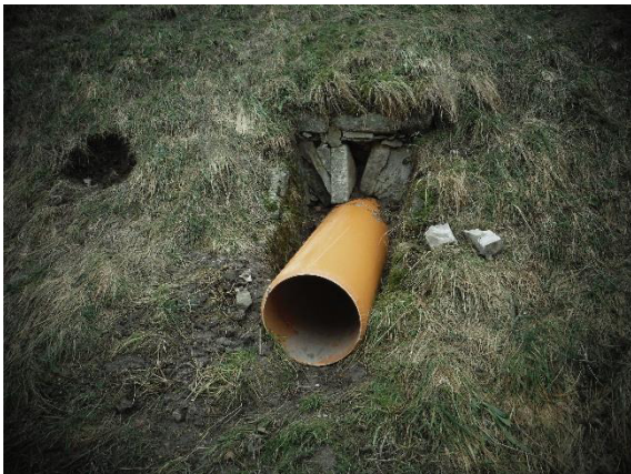
Abbildung 11: Ansicht Ende Bahndurchlass auf südlicher Dammseite, bei Gebäude Nr. 58
