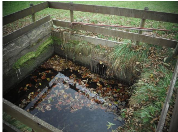
Abbildung 31: Einlauf in Eindolung beim Weiher bei Gebäude Nr. 95
