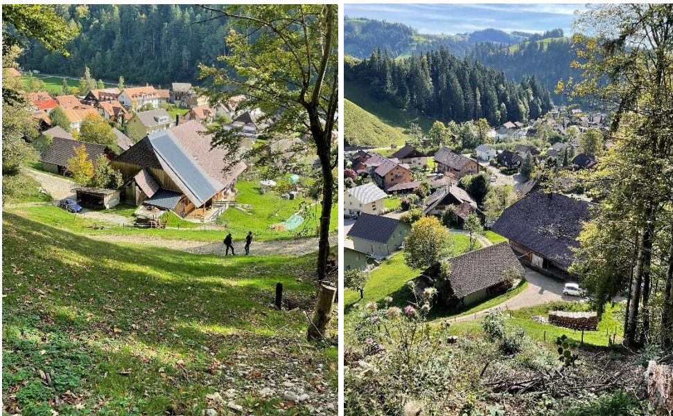
Abbildung 7: Blick von den relevanten Anrissgebieten zu den bestehenden Gebäuden. Links: Oberhalb des Bauernhauses; rechts: oberhalb des Nebenhauses. Foto vom 11.10.2021.
